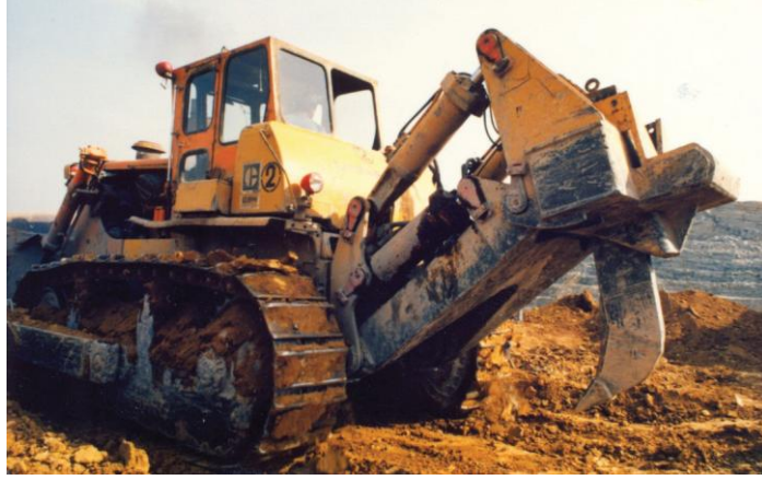
Şekil 2. Örtü kazı işlerinde sökme uygulaması (Göktan ve İphar, 2013)
