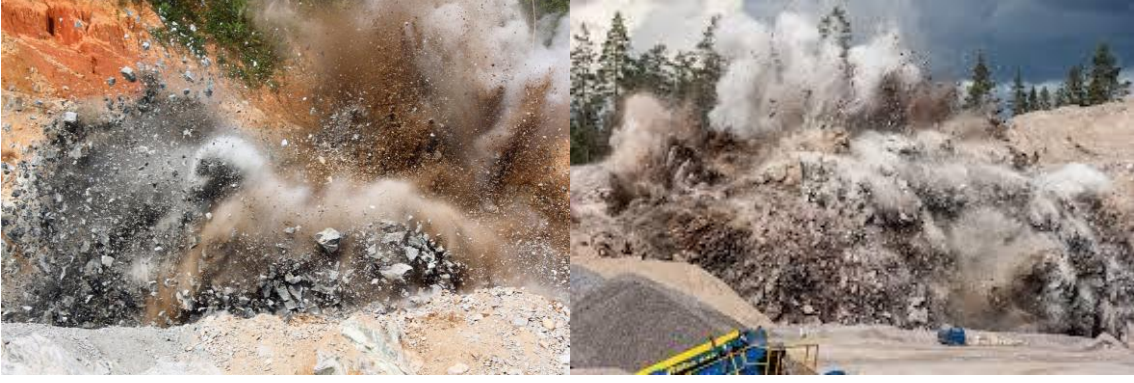
Şekil 4. Patlayıcı madde kullanarak yapılan sökü örnekleri
