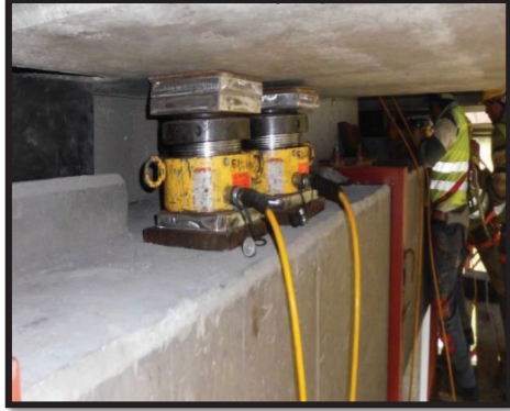
Resim 10. Kriko ile Döşeme Kaldırılıp Mesnet Değişimi Çalışmaları: Askeri Saha Üstgeçit Köprüsü/V2 Nurtepe Viyadüğü
