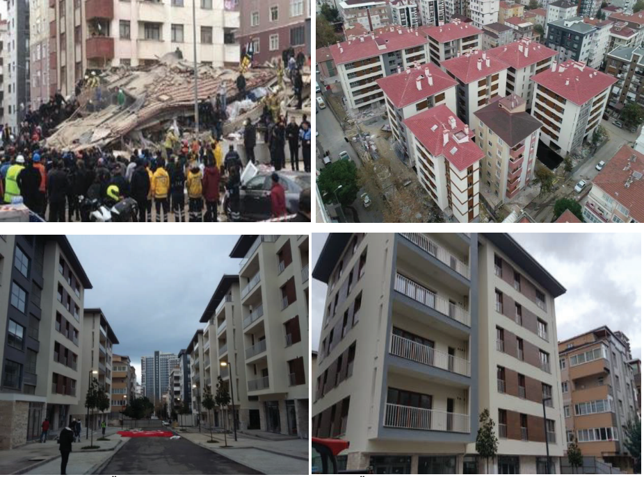
Resim 57. İstanbul İli, Kartal İlçesi, Orhantepe Mahallesi'nde Kendiliğinden Göçmüş Olan Yeşilyurt Apartmanı / Kartal Kentsel Dönüşüm Projesi Çerçevesinde Üretilen Güvenli Konutlar
