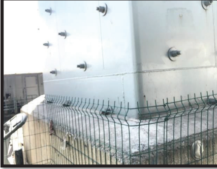
Resim 9. Çelik Mantolama Çalışmaları: Haliç Köprüsü/Mecidiyeköy Viyadüğü
