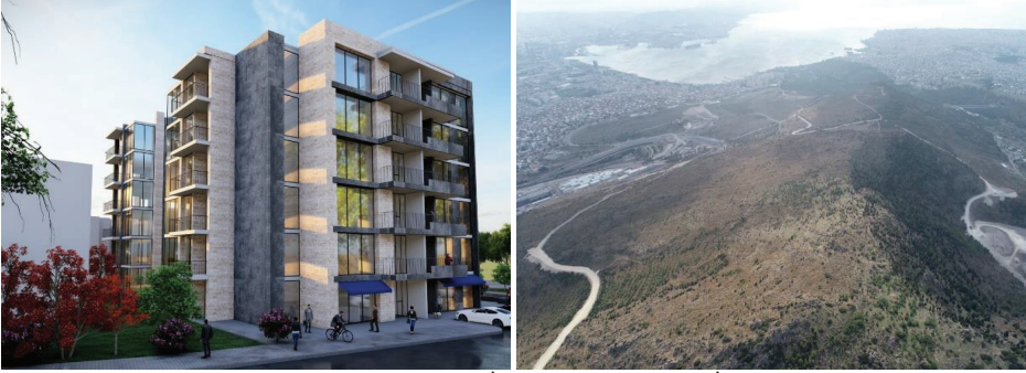
Resim 56. 7. Proje Alanı (42 konut-8 iş yeri) / Bayraklı Rezerv Yapı Alanı
