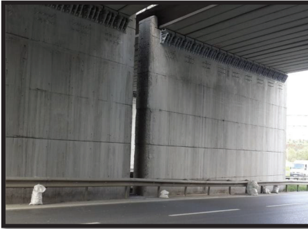
Resim 11. Kiriş Oturma Payı Genişletme ve Yanal Deprem Takozu İlavesi Çalışmaları: İmar Yolu Altgeçit Köprüsü
