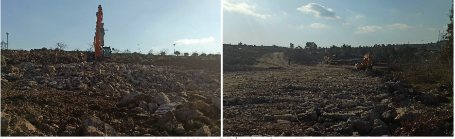
Resim 52. Rezerv Yapı Alanı Kazı ve Kırım Faaliyetleri
