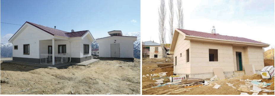
Resim 48. Doğanyol İlçesi Köy Evi ve Ahır İnşaatları / Battalgazi ilçesi Köy Evi İnşaatı
