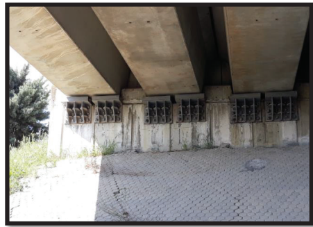
Resim 11. Kiriş Oturma Payı Genişletme ve Yanal Deprem Takozu İlavesi Çalışmaları: İmar Yolu Altgeçit Köprüsü
