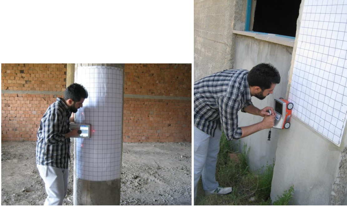
Şekil 5. Kolon ve perde duvarda radar ölçüsü alınırken çekilen fotoğraf.
