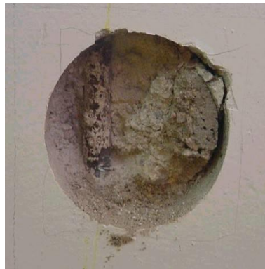
Şekil 14. Taşıyıcı bir elemanda donatının kesilmesi.
