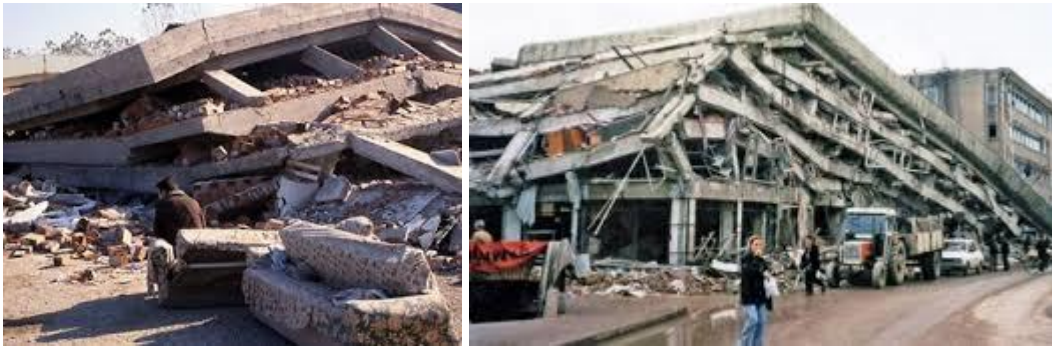
Şekil 3. Hem zemin hem de üst yapı yetersizliğinin sebep olduğu yapı hasarları.
