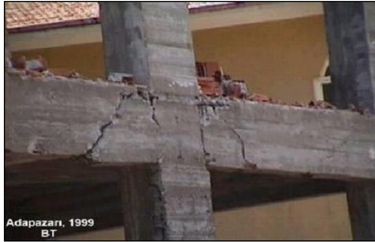
Şekil 22. Kirişte kesme kuvvetini karşılayacak sıklıkta etriye bulunmaması nedeniyle oluşan kesme kırıklıkları.
